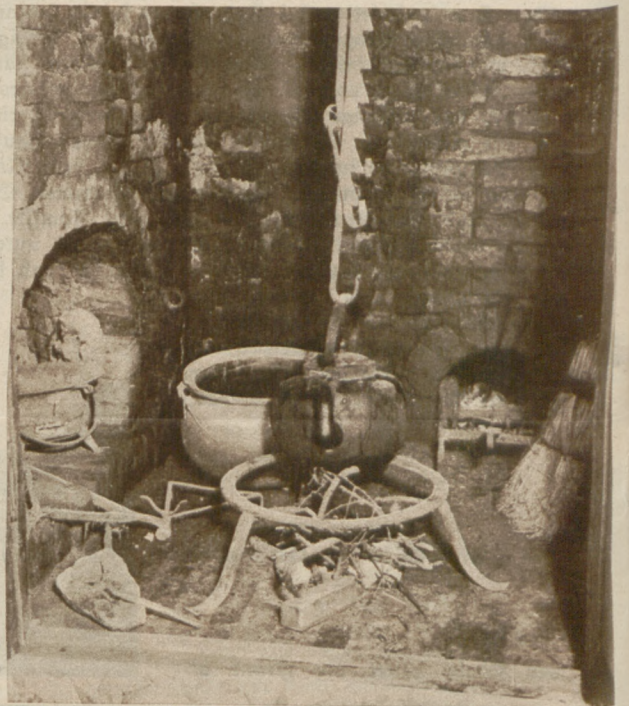
Rechts: Offene Feuerstelle im Schornstein. Rechts geht die Öffnung zum Beilegeofen in der Wohn- stube, links zum Backofen
