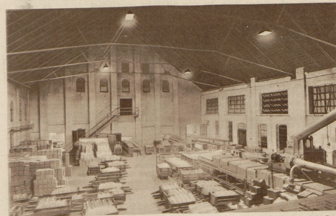
Diese Arbeitshalle wurde früher von einer 300-Watt-Glühlampe beleuchtet. Jetzt brennen an ihrer Stelle vier Natriumdampf-Lampen von je 70 Watt, zusammen also 280 Watt, mit denen eine mehr als doppelte und überdies gleichmäßiger verteilte Beleuchtungsstärke erzielt wird! — Röhrenfabrik in einem Glaswerk
