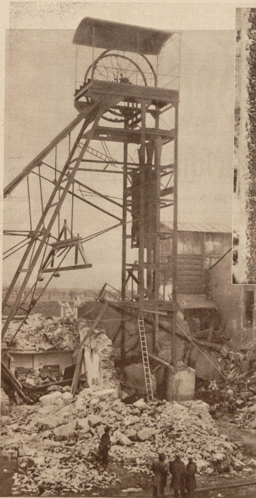
Das Bild der Zerstörung nach der Grubenexplosion auf Grube Nelson III bei Osseg im Böhmerland
