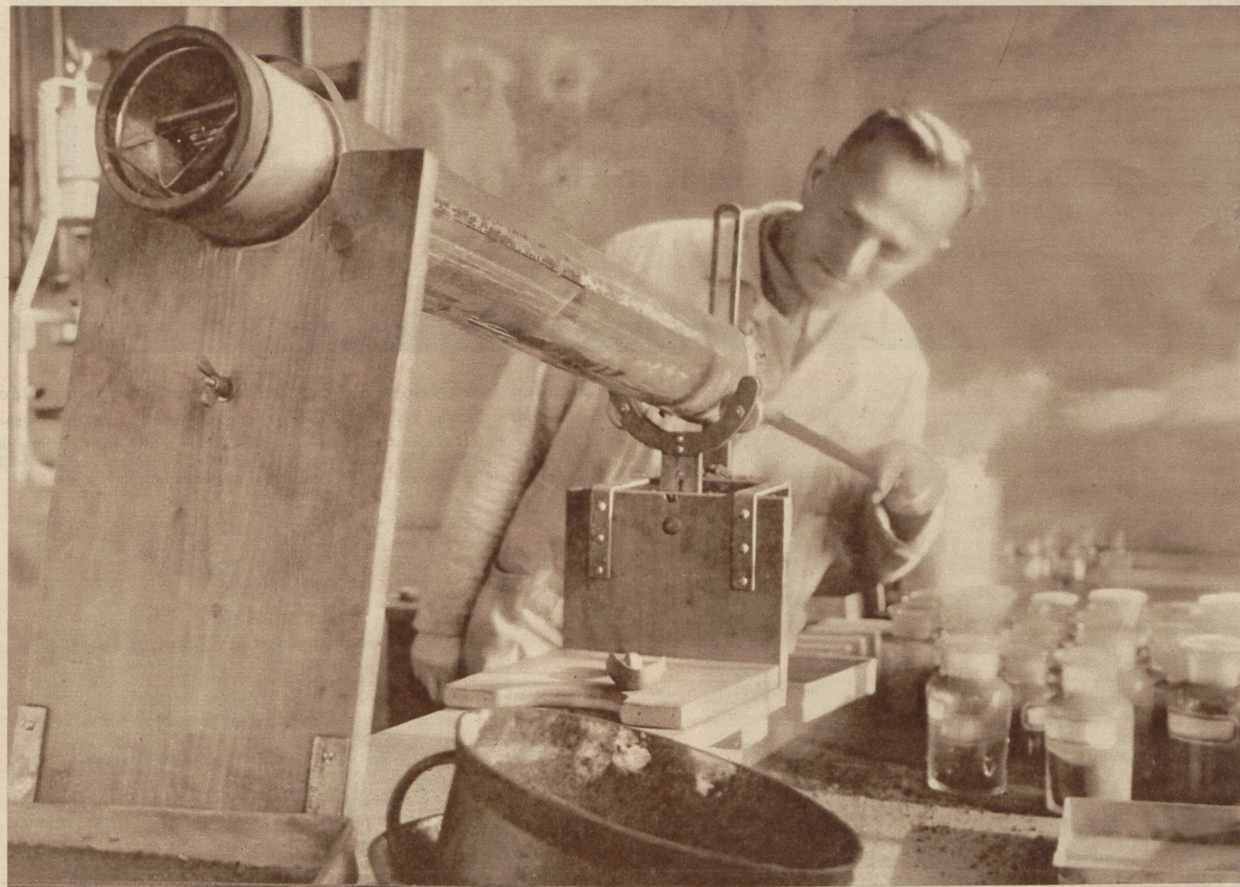
Trockenröhrenmodell aus Glas zur Erforschung der Bewegungsvorgänge von Schüttgütern in Trockenröhren
