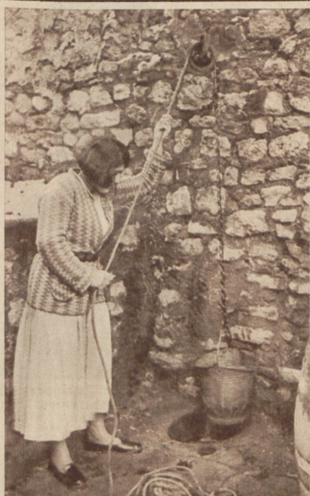
Ein Simer wird in die unterirdische, palastartig anmutende Wasserforschungsanlage gesenkt
