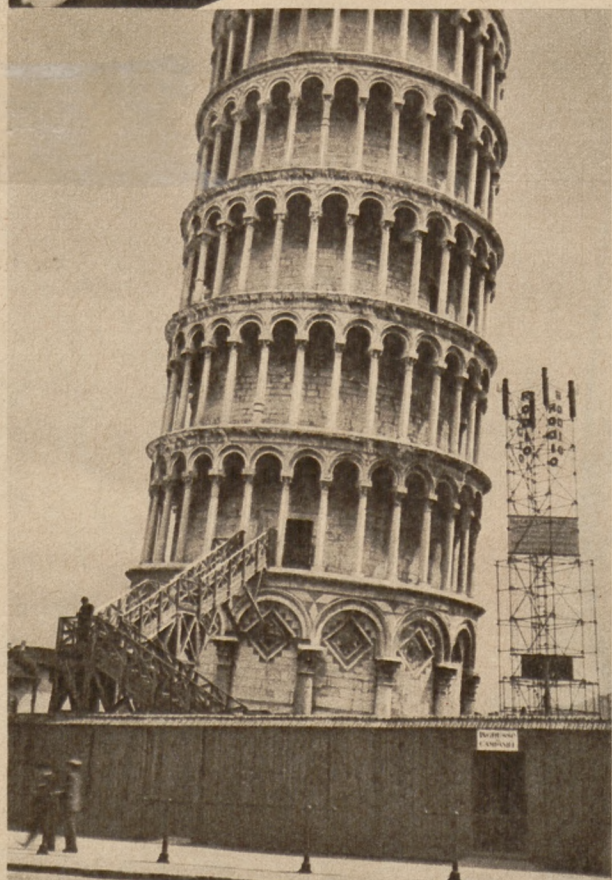
Links: Der Turm von Pisa droht zu wackeln! Unser Bild zeigt ein Photo von den Stützungsarbeiten des weltberühmten schiefen Turmes von Pisa, um den jetzt ein Pfahlwerk gelegt wurde. Der ganze Grund wird mit Zement eingespritzt. Das Publikum darf den Turm trotzdem besteigen, aber nur vom ersten Stock aus über eine der Holztreppe
