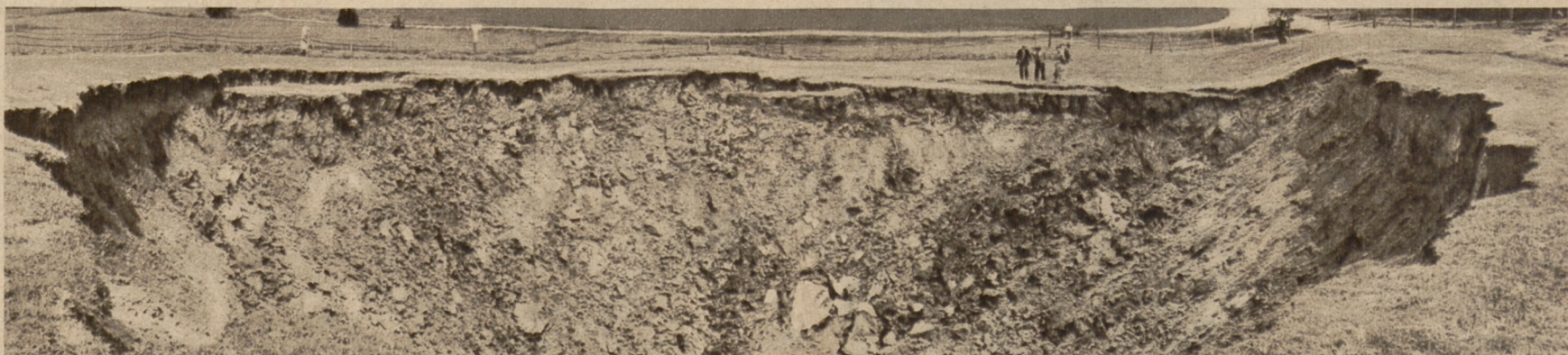
Ein riesiger Erbeinsturz im oberbayerischen Kohlengraben. In Haussham, Ober- bayern, ereignete sich ein Erbeinsturz. 6000 Kubikmeter Erde versanken unter der Oberfläche. Der sich bildende Trichter hatte einen Durchmesser von 35 Meter und eine Tiefe von 17 Meter
