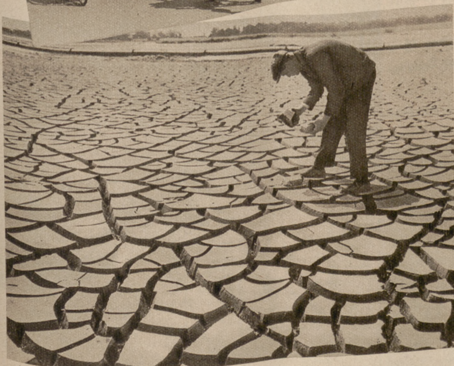
Links: Eine Großtat deutscher Arbeit: Der Rügendamm wird gebaut. — Die auf dem Festland abgelagerte Schlammmasse ist völlig ausgetrocknet und in viele Stücke gerissen
