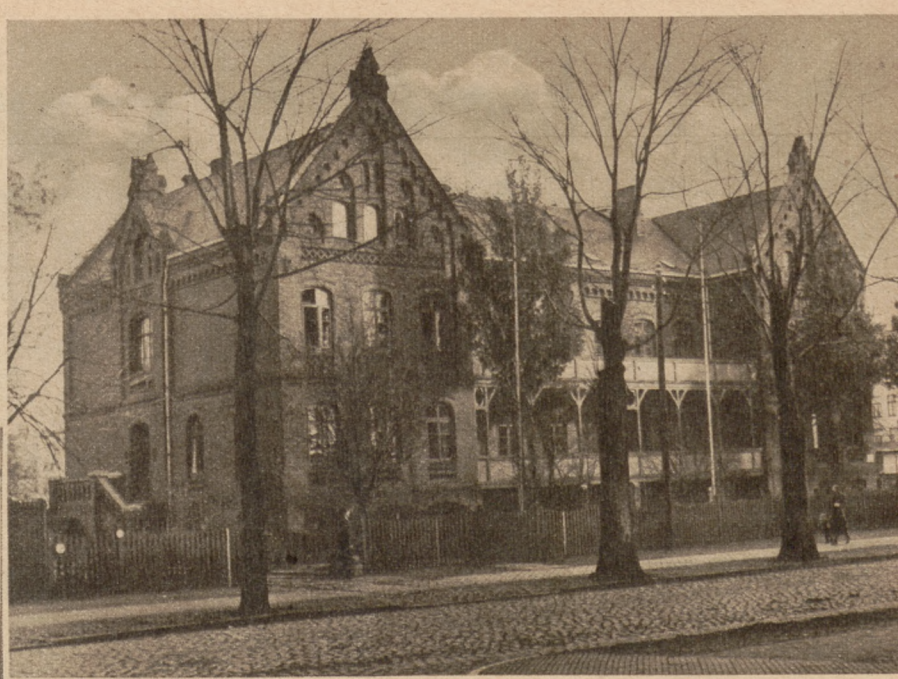
Das Gebäude in Rostock, in dessen Räumen die Lehrlinge ihren handwerklichen Musterbetrieb eingerichtet haben
