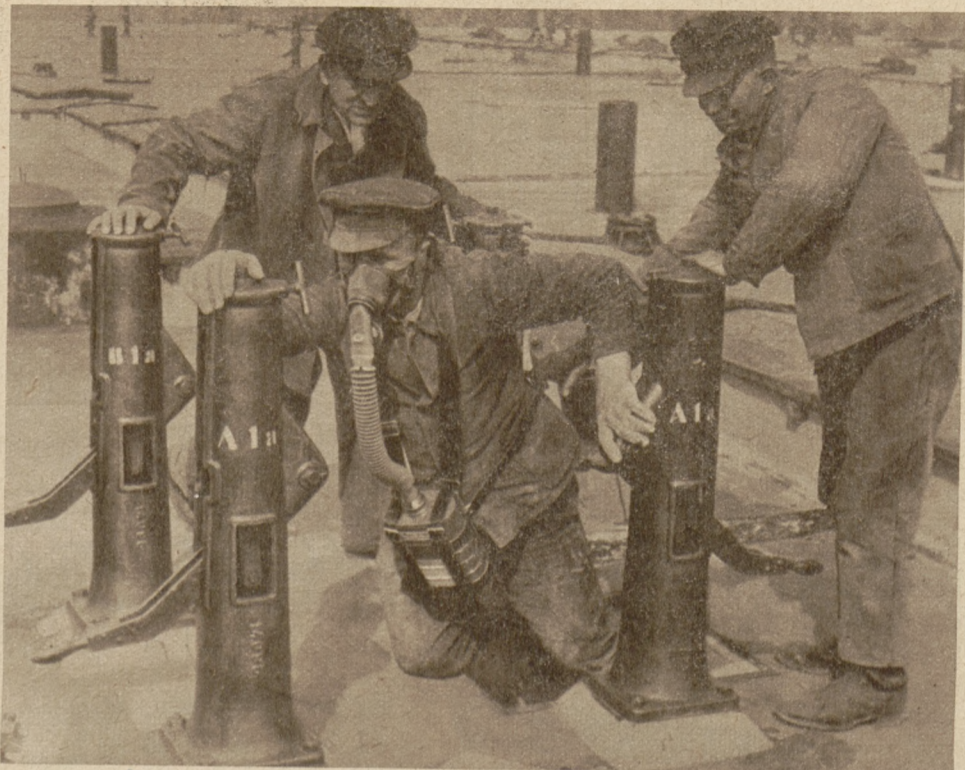
Die Vorrichtungen zum Auffangen des Faulgases müssen von Zeit zu Zeit gereinigt werden Die Arbeiter tragen hierbei zum Schutz gegen Atembeschwerden Gasmasken. Ein Arbeiter kehrt aus dem Gasschacht zurück
