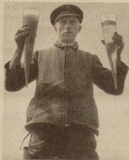
120 000 Kubikmeter Abwässer, von denen der Glasbehälter links im Bild eine Probe zeigt, werden täglich in der Klärungsanlage gereinigt. Die Probe (im Glasgefäß rechts) zeigt mechanisch-biologisch gereinigtes Wasser
