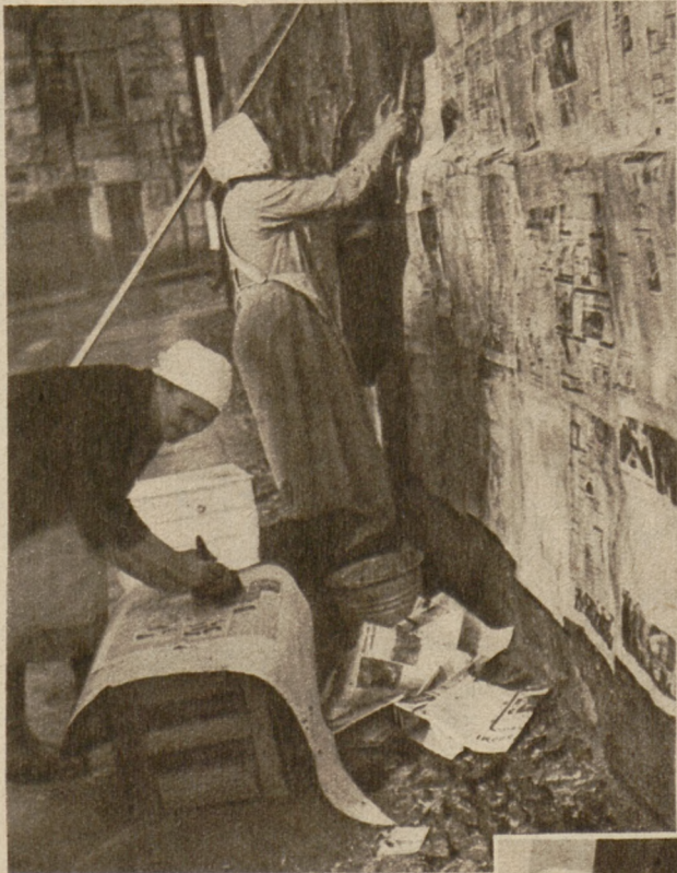
Die finnische Frau ist auch bei Bauarbeiten eine wertvolle Arbeitskraft. Bevor ein Haus verputzt wird, wird es mit Zeitungen verkleistert.
