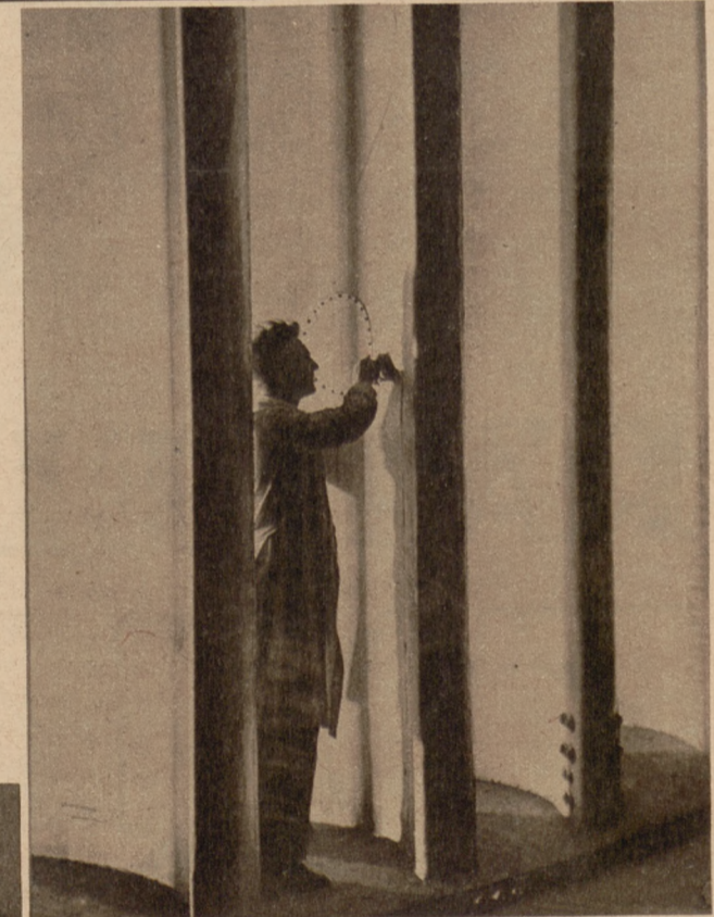
Teilanzeige der Umlenk-Schaukeln im Windkanal Durch die Schaukeln wird der Windstrom mit möglichst geringem Energieverlust im rechten Winkel umgelenkt
