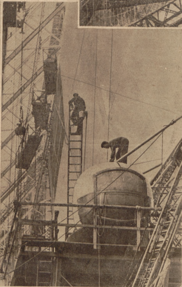
Vor der Montage ruht die Motorengondel auf einem hochgebauten Gerüst. Dahinter arbeitet auf einer hohen Leiter der Anstreicher
