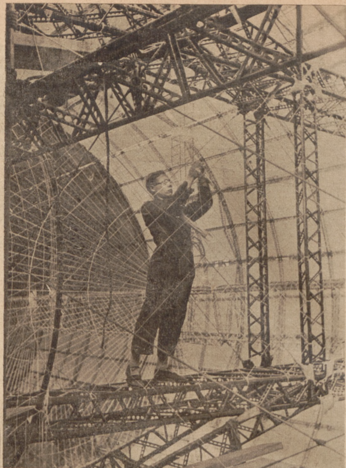
Im Innern des Luftschiffzumpfes werden Netze gespannt, die später die Gaszellen aufnehmen
