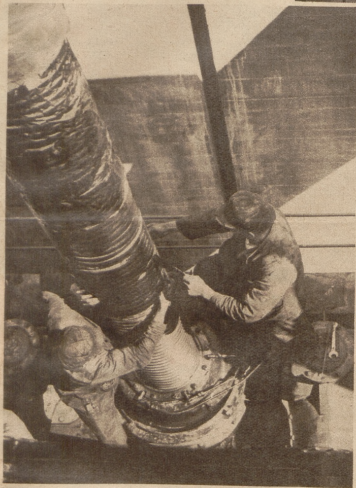
Links: Eine der 27 m langen Spindeln, an denen der Schiffstrog auf- und niedergerollt, wird von der Verpackung freigemacht
