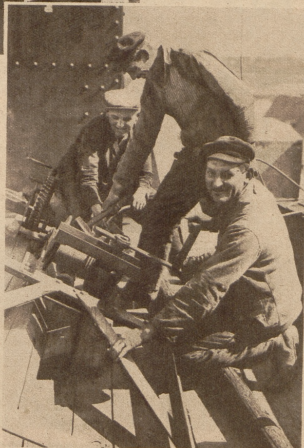
Links: Eine der 27 m langen Spindeln, an denen der Schiffstrog auf- und niedergerollt, wird von der Verpackung freigemacht
