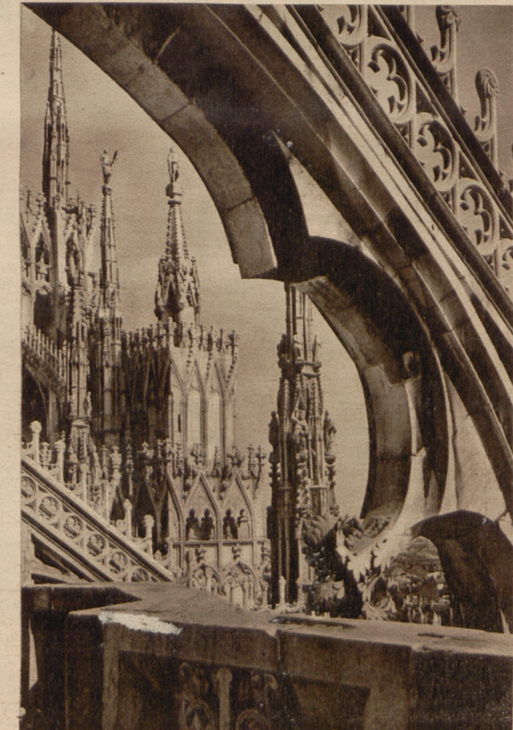
Der Mailänder Dom, der ganz aus weißem Marmor gebaut ist. Mit vom Dach durch Strebebeulen und Bögen.
