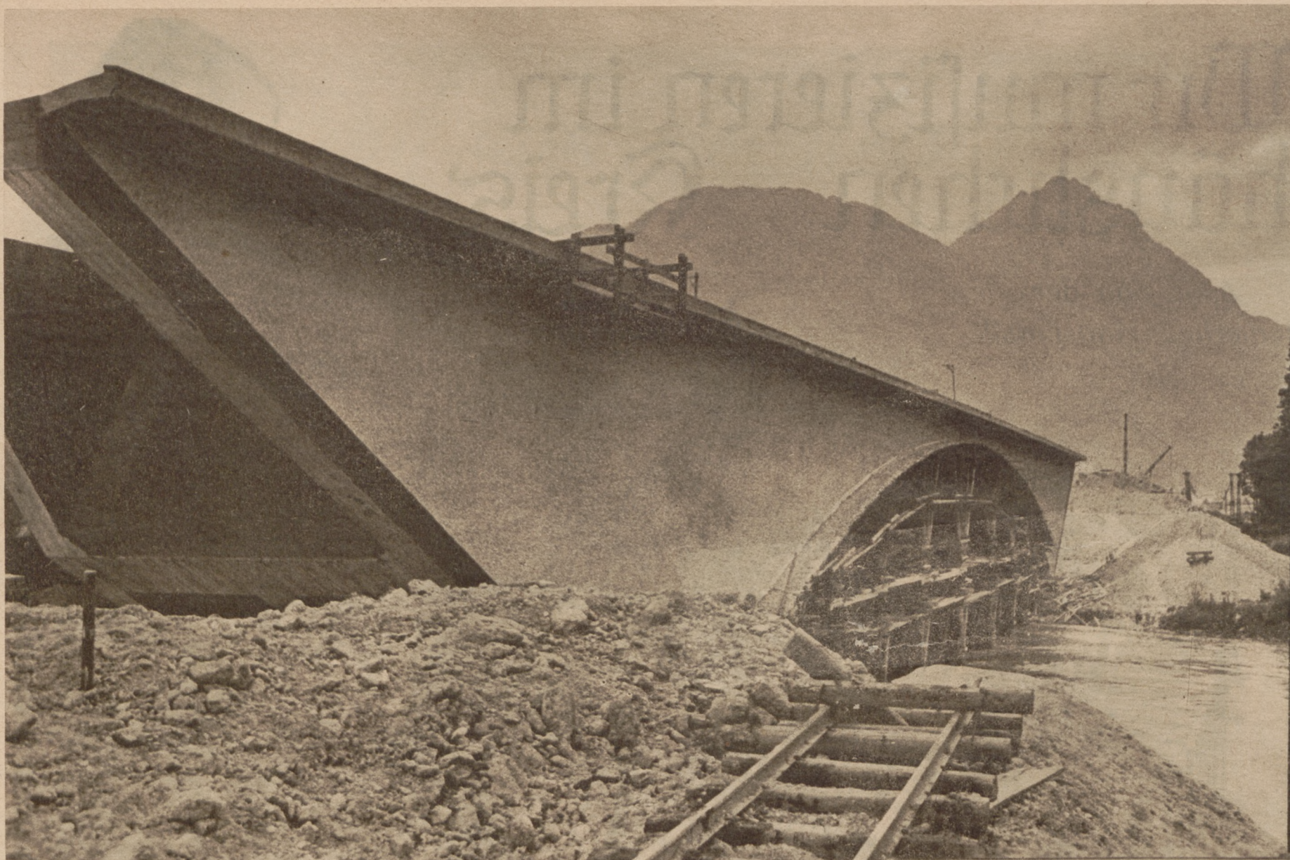
Links: Der erste Bogen der Reichsautobahn- brücke über die Saalach ist bereits fertig
