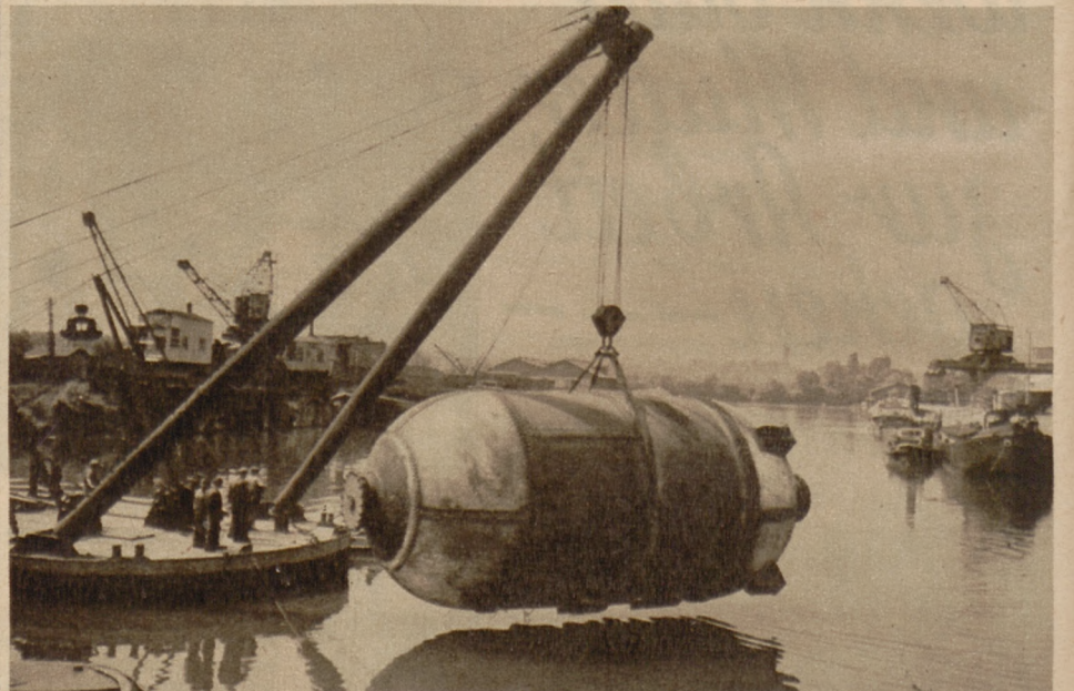
Der Eisenbahnwagen war zu klein — da schwamm er allein auf dem Main Dieser Zerkulofekocher konnte wegen seiner Ausmaße nicht mit der Bahn transportiert werden. Da er vollkommen luftdicht gearbeitet war, entschloß man sich, ihn mainaufwärts an seinen Bestimmungsort zu schleppen, der ebenfalls am Wasser gelegen ist. Der Kessel wird zu Wasser gelassen Scherl Deutschland beteiligte sich mit 1000 Turnern und Turnerinnen an diesem großen Gymnastikfest der Schweden Täglich marschierten sie vom KdF-Schiff „Wilhelm Gustloff“, das sie nach Stockholm brachte und auf dem sie während der Dauer der Veranstaltung untergebracht waren, zum Stockholmer Stadion Atlantic
