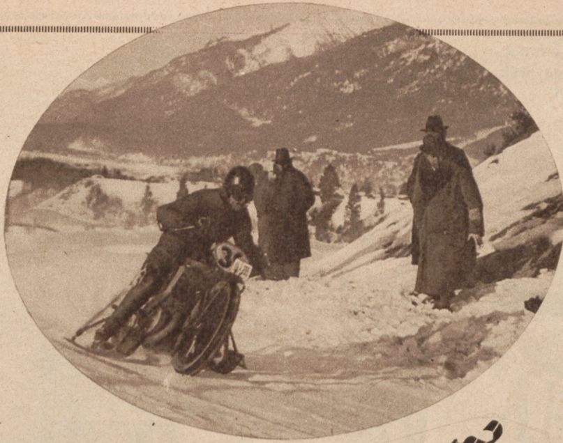
Das Motorrad mit Kufen stellt eine Verbindung dar zwischen Schneeschuh und Motorrad. Für Fahrten auf verschneiten Wegen soll es sehr nützlich sein. Hoepfner
