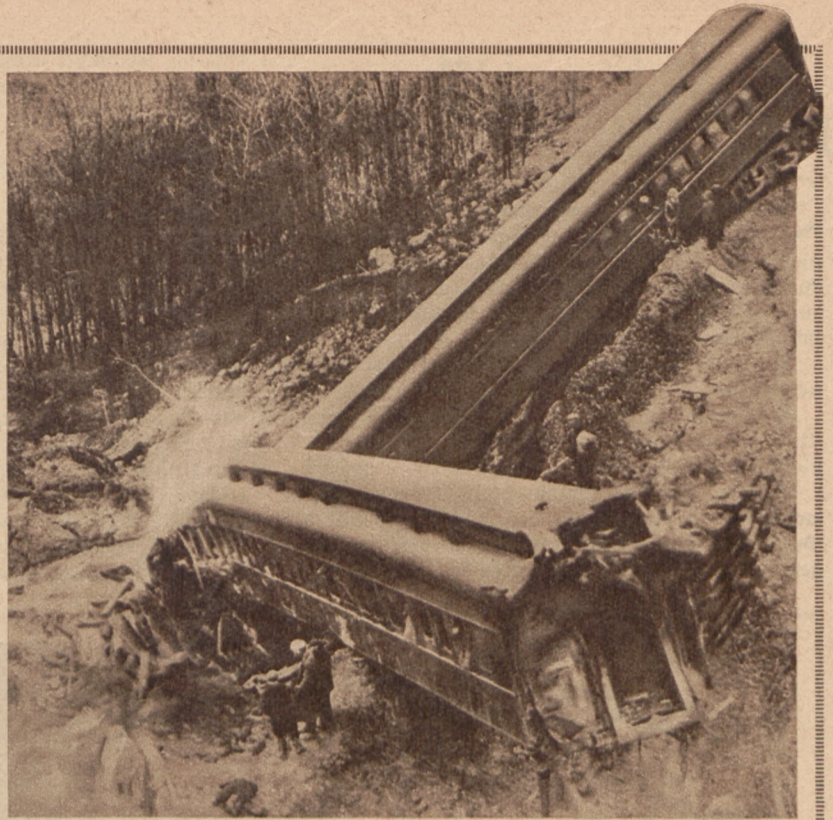
Eine eindrucksvolle Aufnahme des schweren Eisenbahn- unglücks in Hamil- ton (Nordamerika). Einige Wagen des Zuges stürzten den Bahndamm hinunter, da infolge starker Re- gengüsse der Unter- bau der Strecke unter- waschen war. S.B.D.
