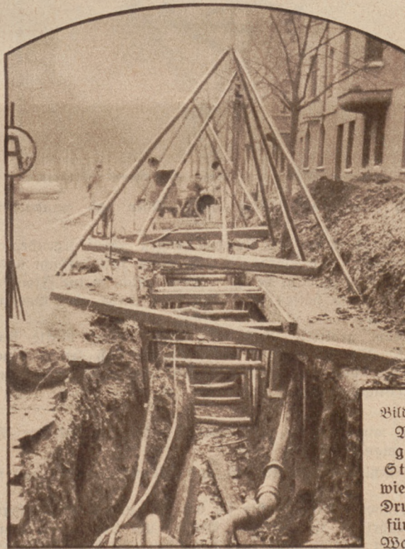
Der Abzweig einer Gasleitung vom Hauptrohr in der Straße wird zwecks Hausanschluss installiert
