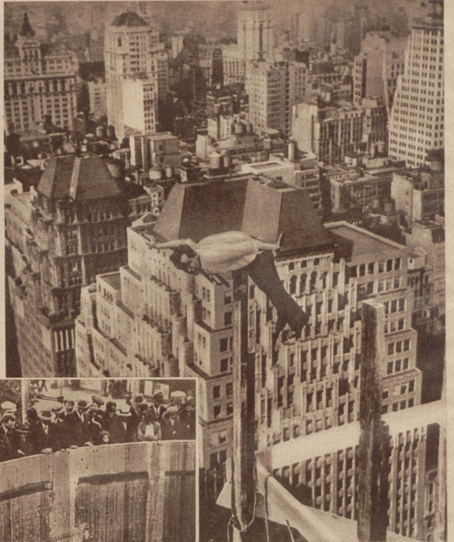
Gefährlicher Ehrgeiz: Ein Akrobat vollführt auf einem New Yorker Neubau in Höhe von 44 Stockwerken halbschwebende Kunststücke S. B. D.
