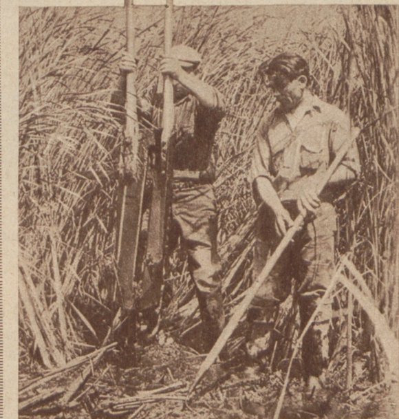
Handbagger zum Ausheben von Abzugsgräben in den von Miasmen verseuchten Sümpfen
