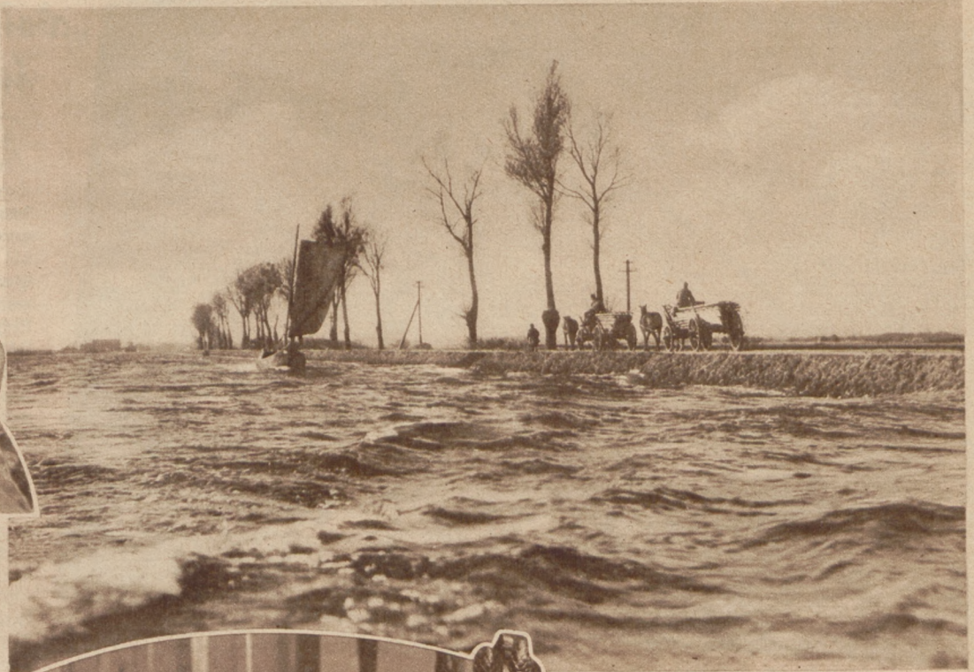
Aberschwemmung in Ostpreußen Das weite Moorgebiet, das sich unweit von Labiau ausdehnt, und das schon seit mehr als 100 Jahren dauernd urbar gemacht werden sollte, befindet sich noch heute in einem fast unbebaubaren Zustande. Während im Sommer der sogenannte Moosbruch, herrliche Weide, durchzogen von zahllosen Kanälen, ein fast holländisches Bild bietet, beginnen mit dem Herbst die großen Uberschwemmungen, die mit dem Eisgang des Winters ihren gefährlichen Höhepunkt erreichen. Der Wind treibt dann die Eisschollen weit ins Land, die Häuser, Brücken und Menschen fortreißen. Oft genug müssen die Bewohner dann auf den Hausböden wochenlang wohnen, bis sich der Eisgang verlaufen hat. Mit dem Einsetzen des Sommers kommt dann Ruhe für die Bewohner und das Vieh kann mit Rähnen zu den fetten Weideplätzen gefahren werden. Ein eigenartiges Bild. Dicht neben der Straße, auf der der Kahnwagen fährt, läßt der Fischer sein Segelboot treiben E. B. D.
