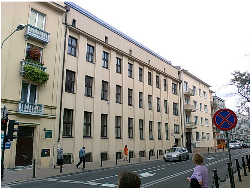
Dawna siedziba Izby Przemysłowo-Handlowej w Lublinie przy ul. Okopowej. Stan obecny. Autor: Karol Dąbrowski
