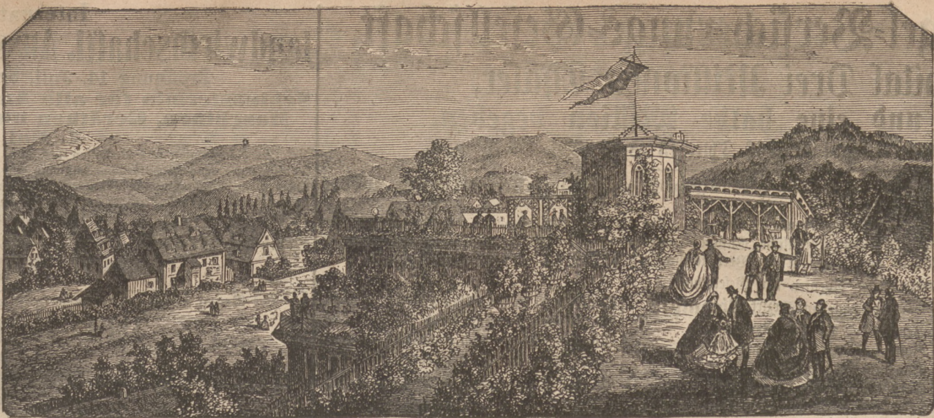
Ansicht der mit Holz-Cement gedeckten Weinhalle des Carl Samuel Häusler, Erfinder des Holz-Cements in Hirschberg in Schlesien.
