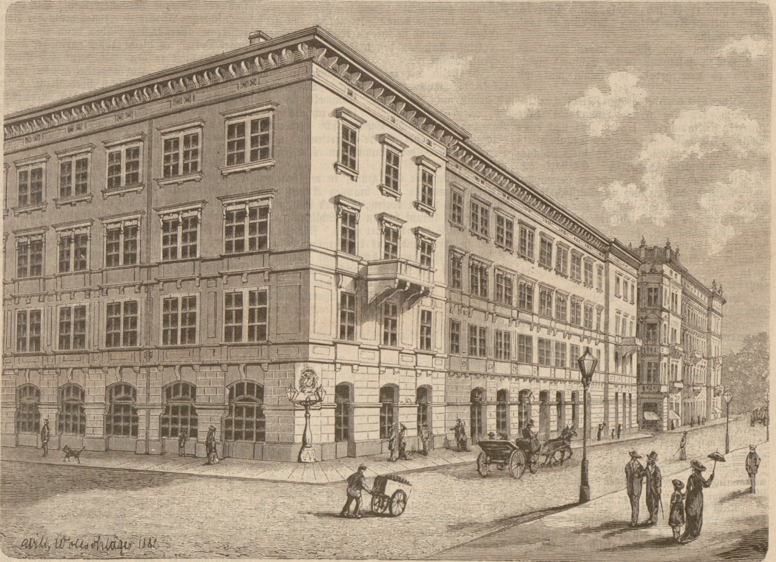
Das Reichsgerichtsgebäude in Leipzig.
