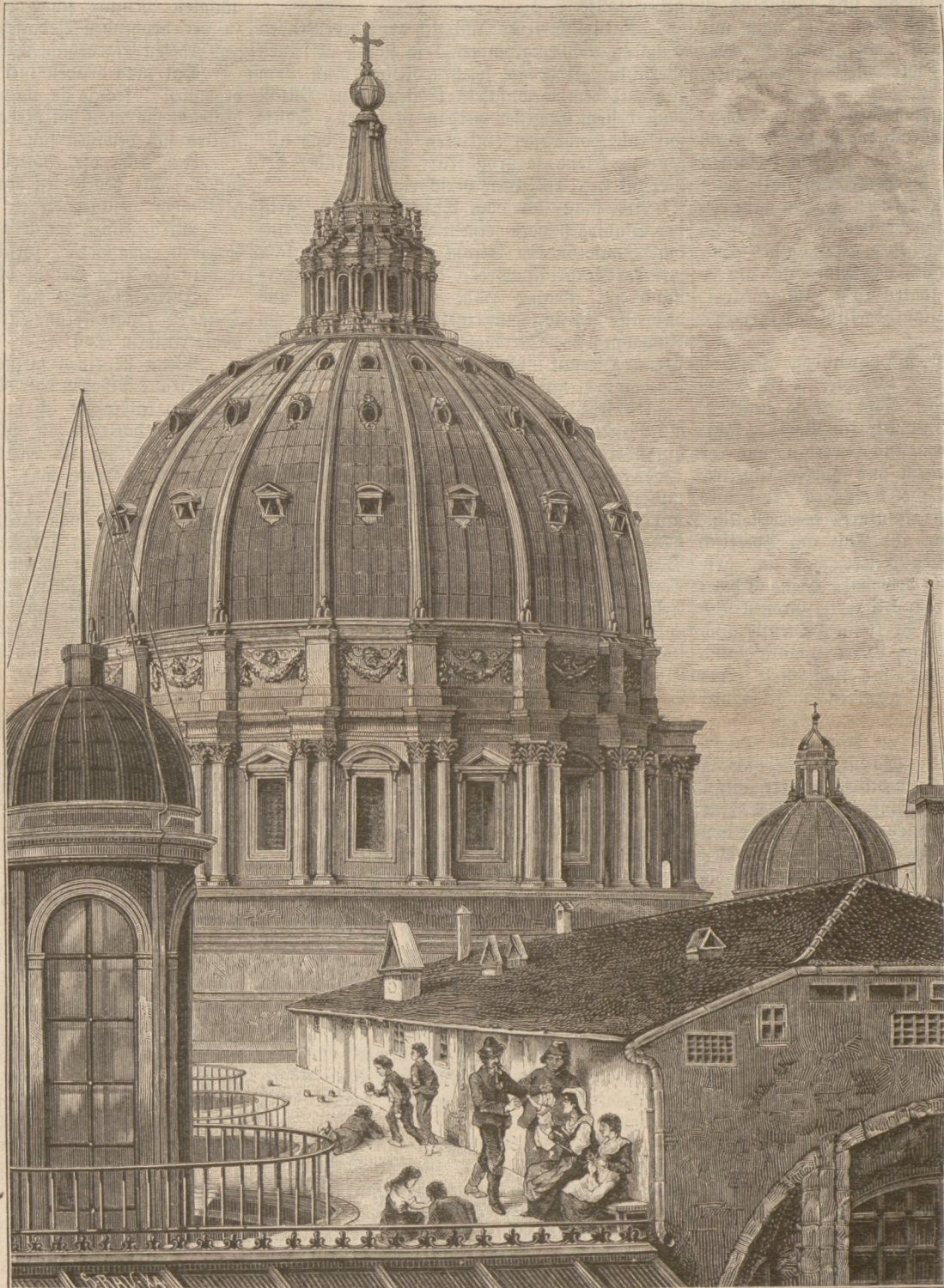
Auf dem Dache der St. Peterskirche in Rom.
