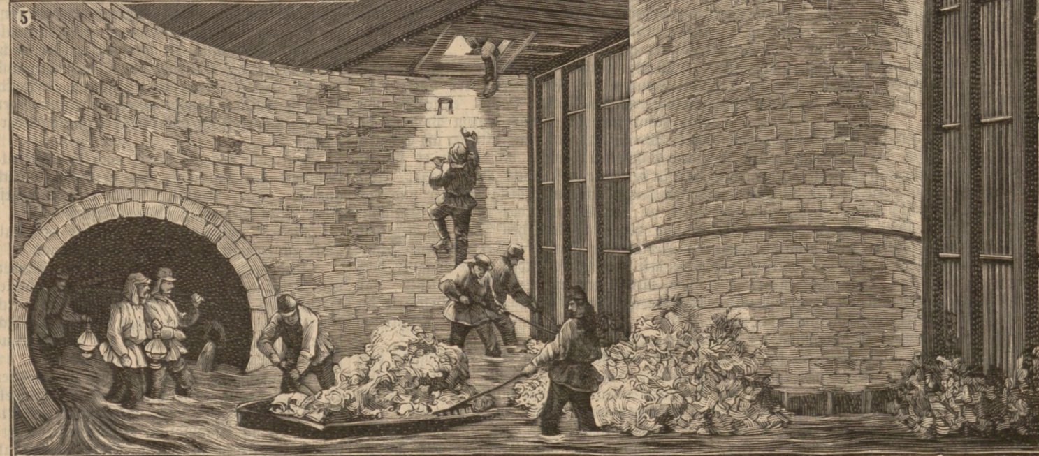
1. Sammelpunkt von kleineren Kanälen. 2. Einsteigegschacht an der Straßenoberfläche. 3. Vereinigung zweier Hauptsammler. 4. Ansicht eines Hauptsammlers. 5. Sandfang an den Pumpstationen.
