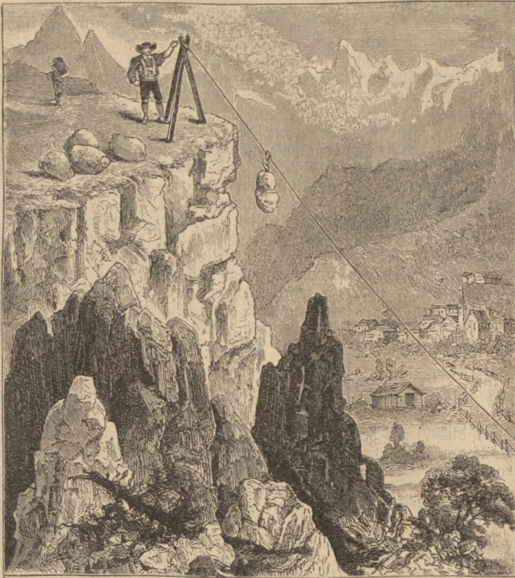
Das Transportiren des frischen Alpenheues in Säcken thalabwärts an gespannten Drahtseilen.
