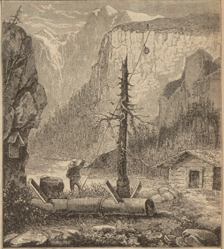
Das Transportiren des frischen Alpenheues in Säcken thalabwärts an gespannten Drahtseilen.
