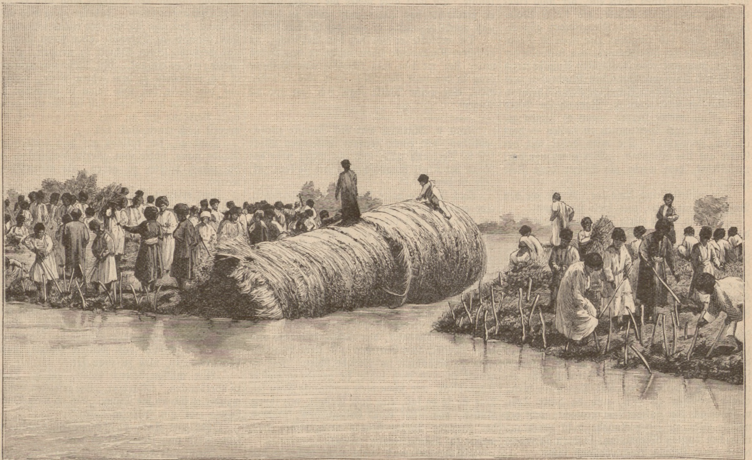
Dammbau in Merw. (S. 171)
