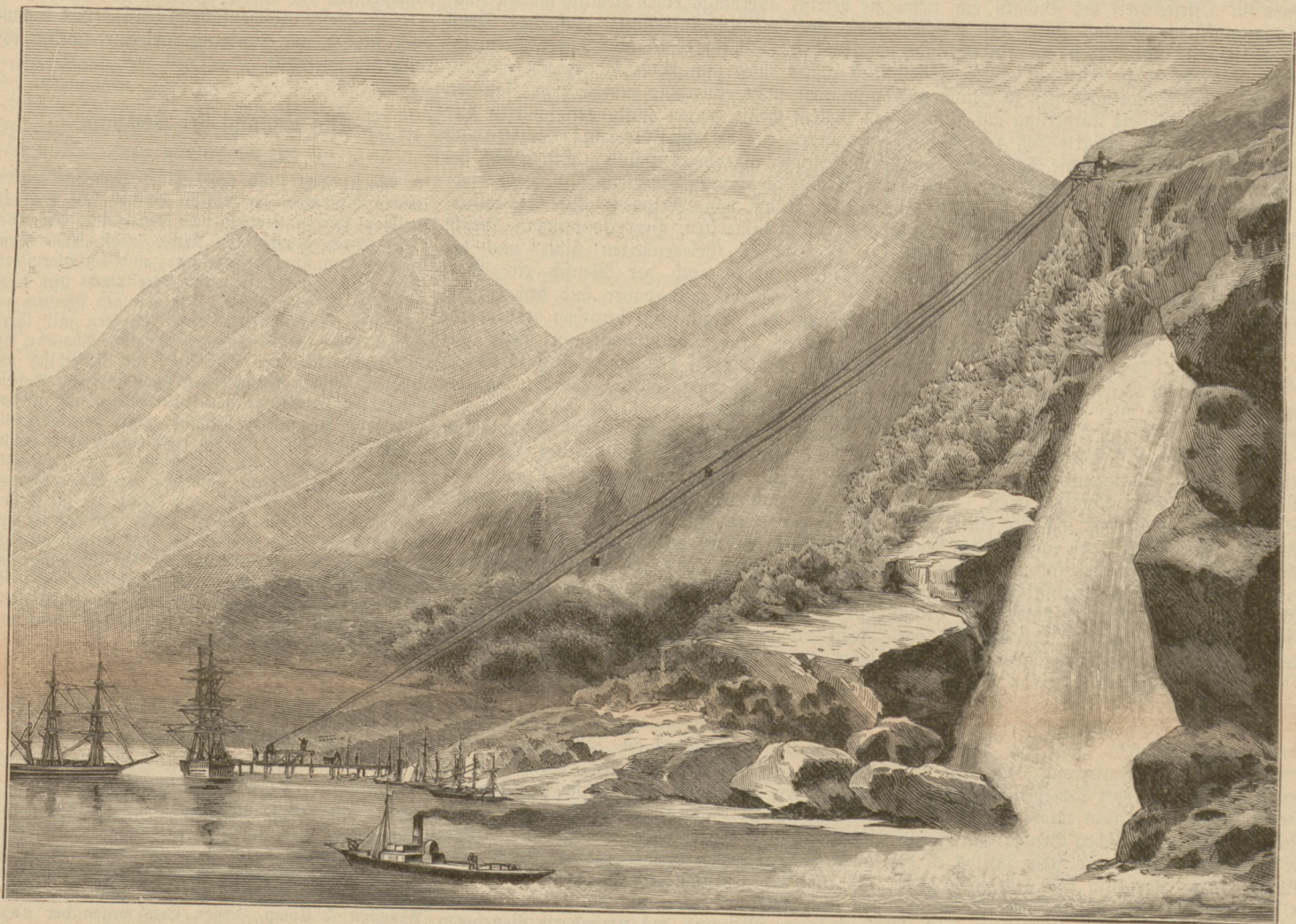
Die Luftbahn für Eisenerztransport bei Alesund in Norwegen. (S. 331)
