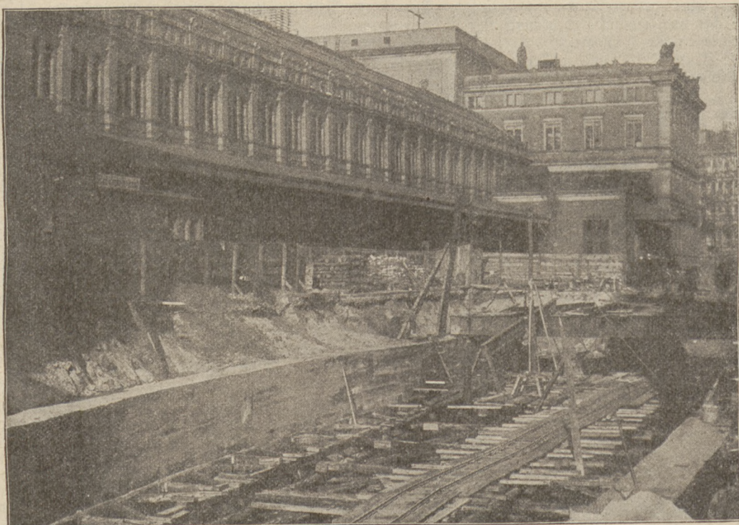
Die elektrische Hoch- und Untergrundbahn zu Berlin: Tunnelbau am Empfangsgebäude der Potsdamer Bahn mit Arbeitsgeleis.
