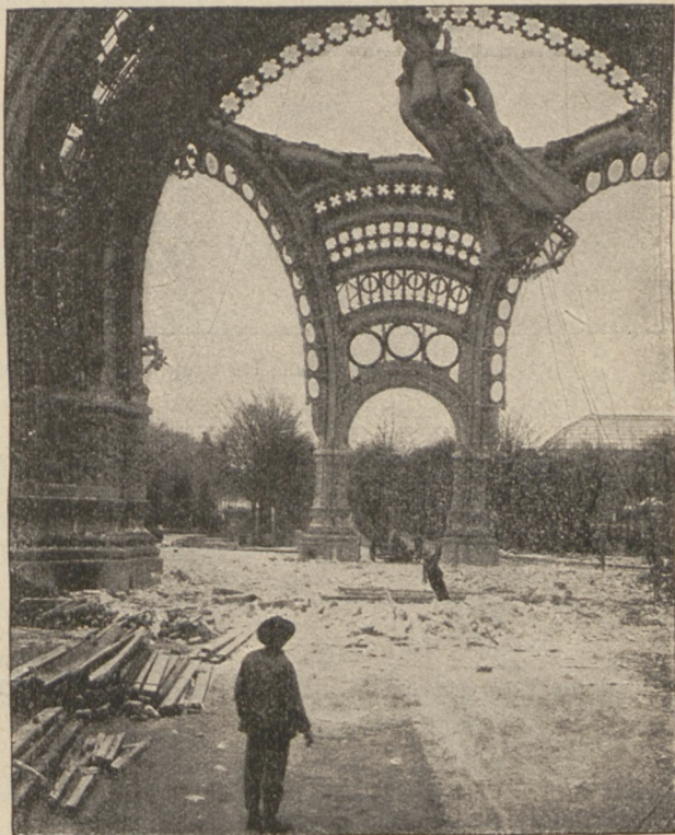
Die Herablassung der Statue „Stadt Paris“ beim Abbruch des Monumentalthores der Pariser Weltausstellung. Nach einer Photographie von V. Grubayeboff in Paris.
