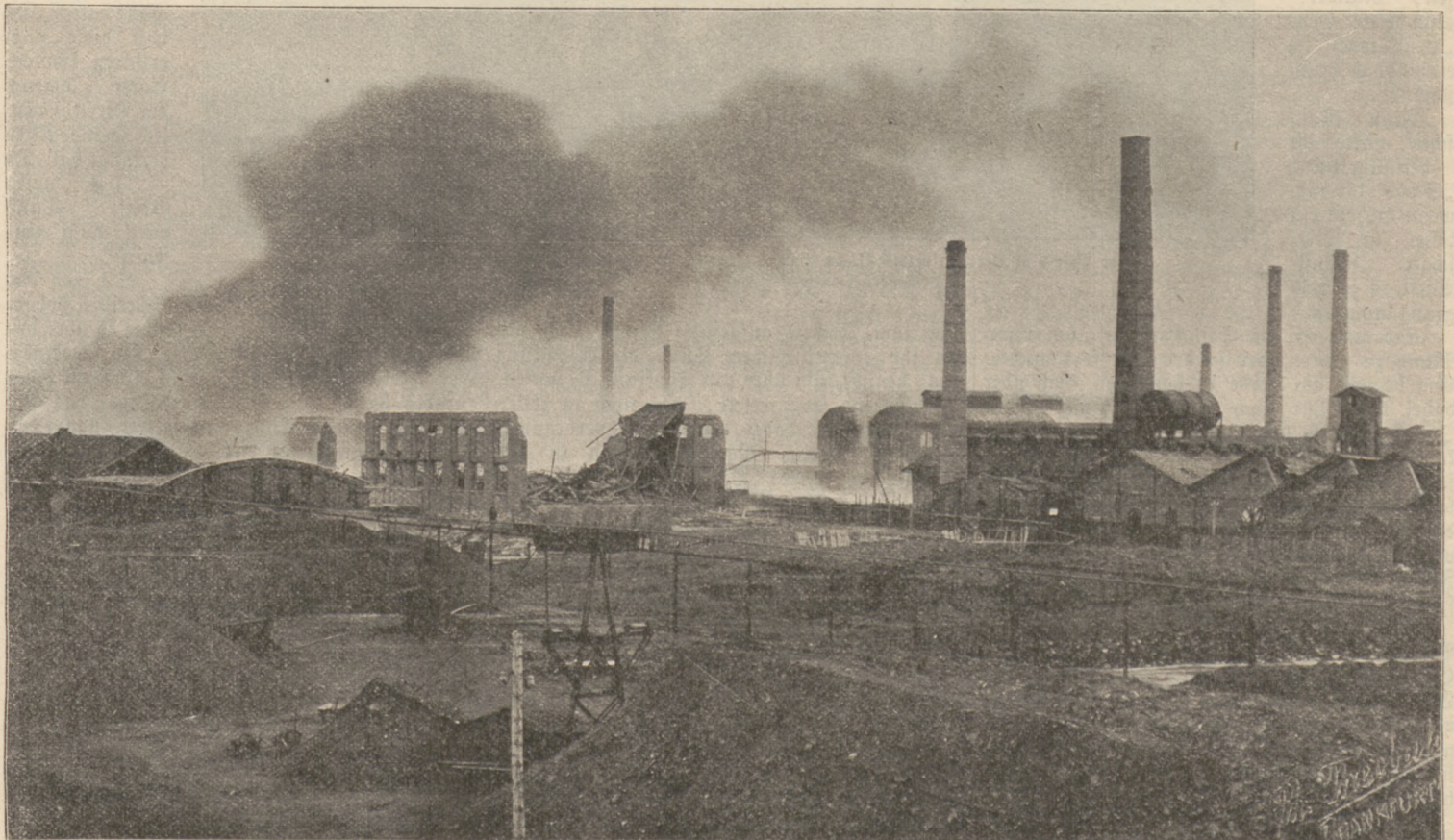
Gesamtansicht der Chemischen Fabrik Griesheim-Elektron in Griesheim nach der Katastrophe. (S. 171) Nach einer Photographie von Ph. Theobald jr. in Frankfurt a. M.
