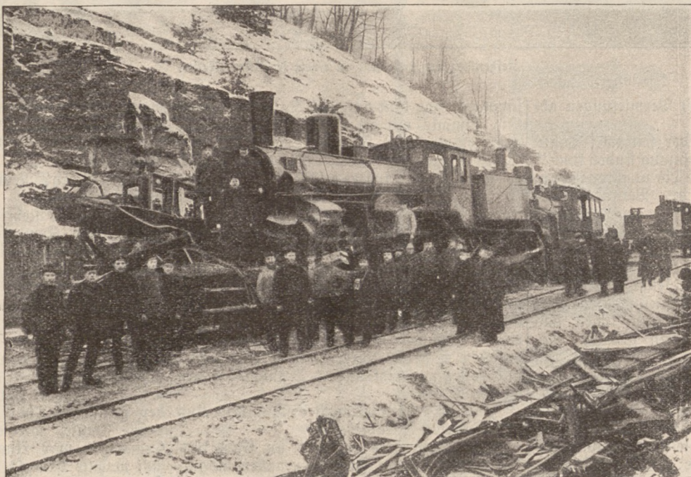
Der Schauplatz des Eisenbahnunglücks bei Altenbeken. Nach einer Photographie von A. L. P. H. von in Paderborn.
