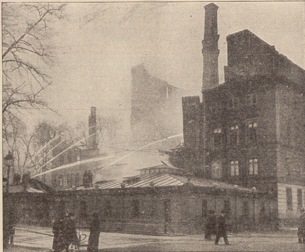
Die Rückseite des königlichen Hoftheaters in Stuttgart nach dem Brande. (S. 59) Nach einer Photographie von Hans Hildenbrand in Stuttgart.
