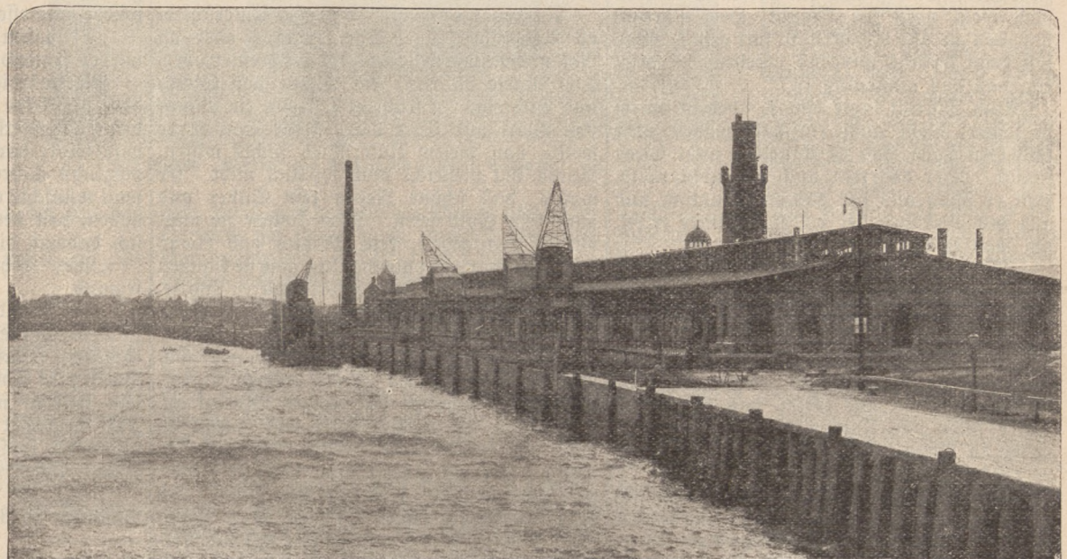
Der neue Schnelldampferhafen in Cuxhaven. (S. 220) Nach einer Photographie von Hans Breuer in Hamburg.
