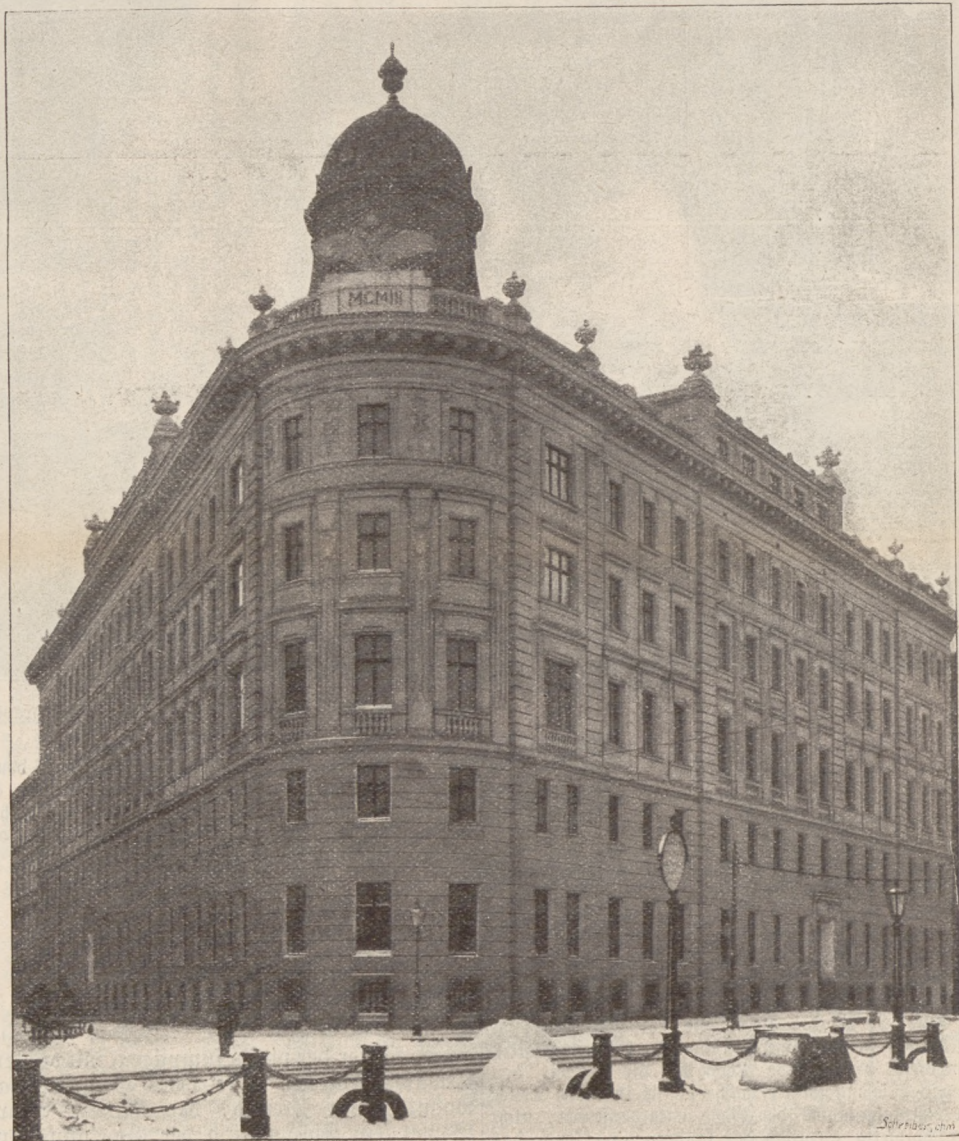
Das neue Post- und Telegraphen-Direktionsgebäude in Wien. (S. 68) Nach einer Photographie von H. Lechner's Hofbuchhandlung (W. Müller) in Wien.
