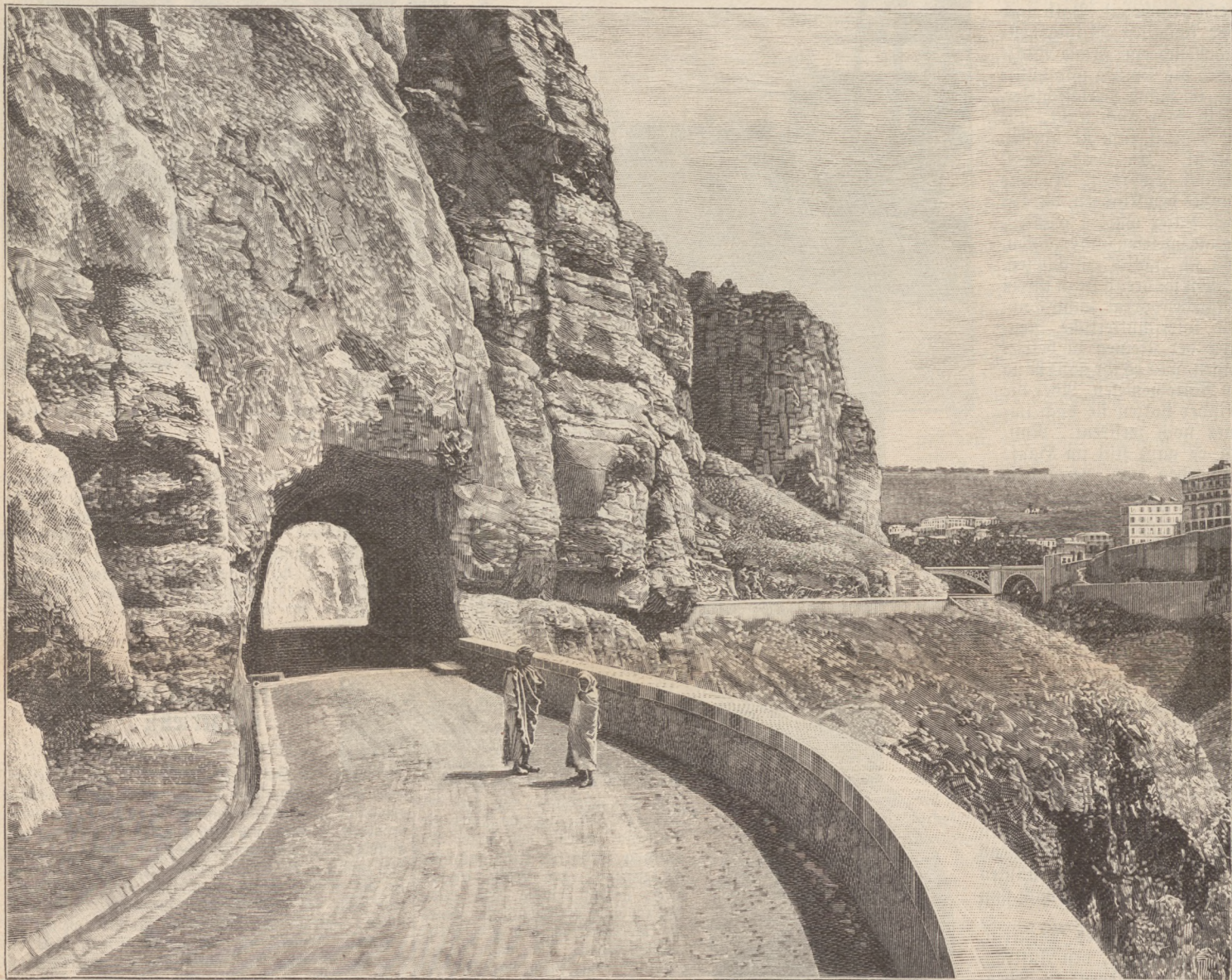
Landstraße längs der Felsklüften des Annel (Algerien). (S. 91)
