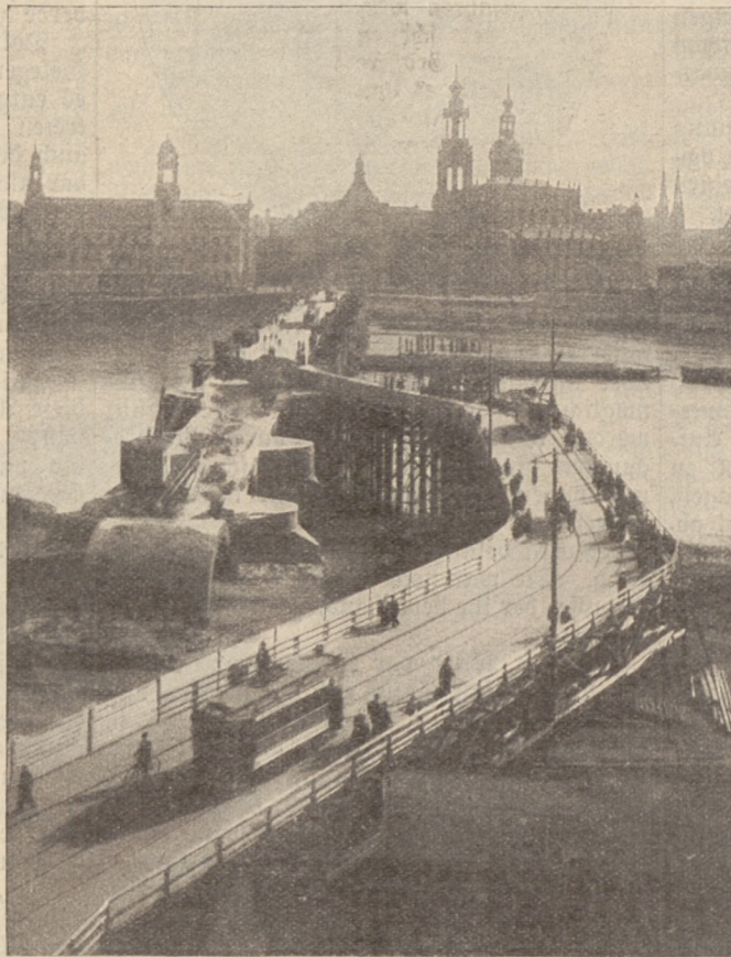
Die im Abbruch befindliche Augustusbrücke nebst Interimsbrücke in Dresden. (E. 182)
