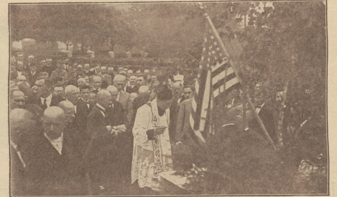
Poświęcenie kamienia węgielnego pod nową Elektrownię Miejską w Ostrowie Wlkp. w dn. 16.VII. 1927.
