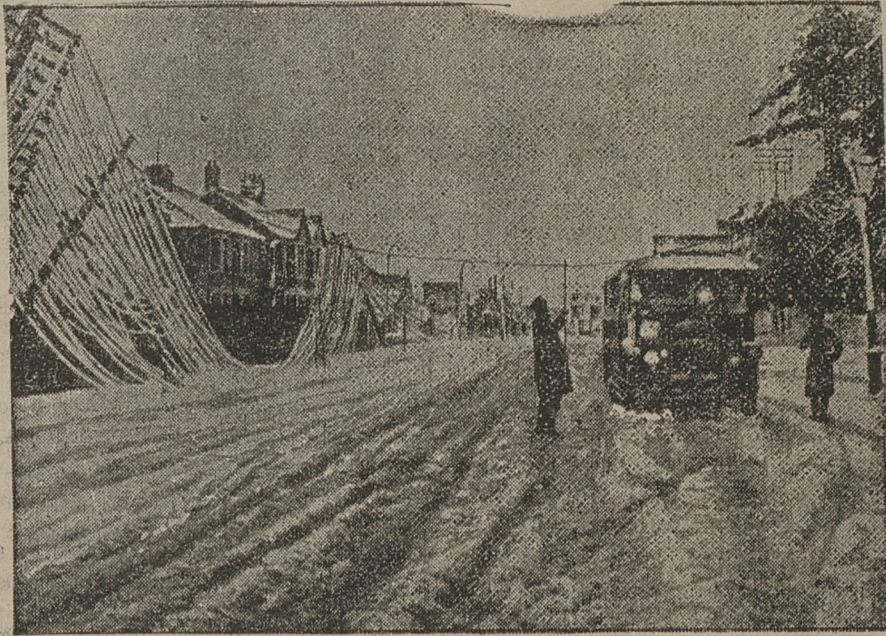
Jak to już donosiliśmy w depeszach, w Anglii spadły ostatnio wielkie śniegi i szalała burza śnieżna. Na ilustracji widzimy zniszczoną linię telefoniczną, skutkiem naporu mas śniegu.
