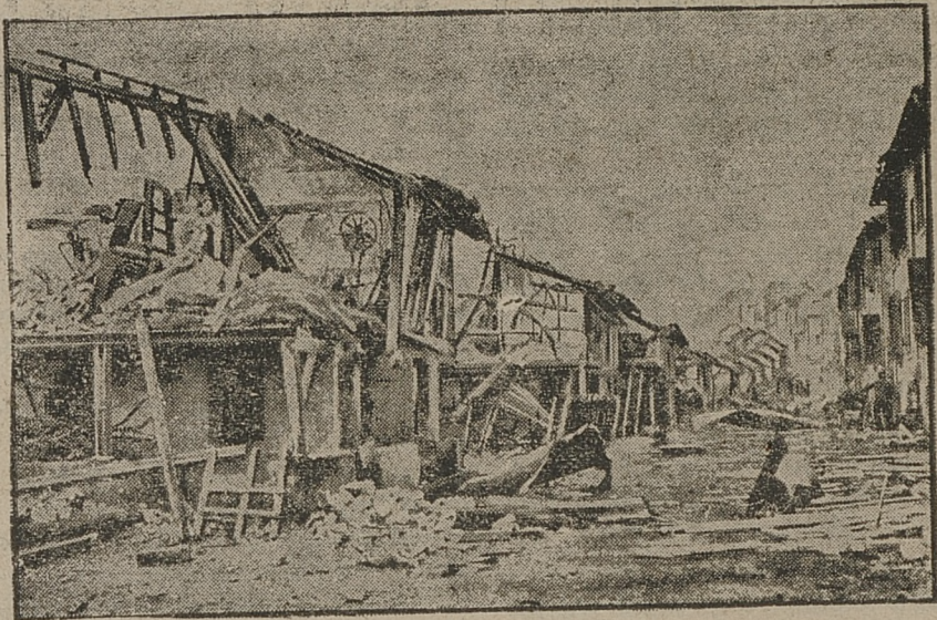
Japonja jest krajem trzęsień ziemi. Ostatnio znów w okolicach Tokio zanotowano silne wstrząsy. Szczególnie tragicznie przedstawia się bilans trzęsienia ziemi w osadzie wojskowej pod Tokjō, gdzie zniszczone zostały magazyny, kaszary i inne budynki.
