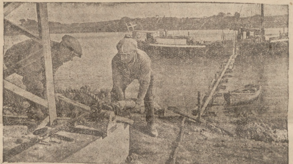
Założenie kabla podmorskiego wymaga wiele pracy. Na ilustracji układanie kabla na pewnym odcinku.
