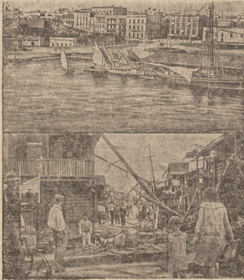
Nad Jawą przeszedł ostatnio cyklon, który wyrządził wielkie szkody. Na zdjęciu jeden z portów przed i po przejściu niszczącego żywiołu.
