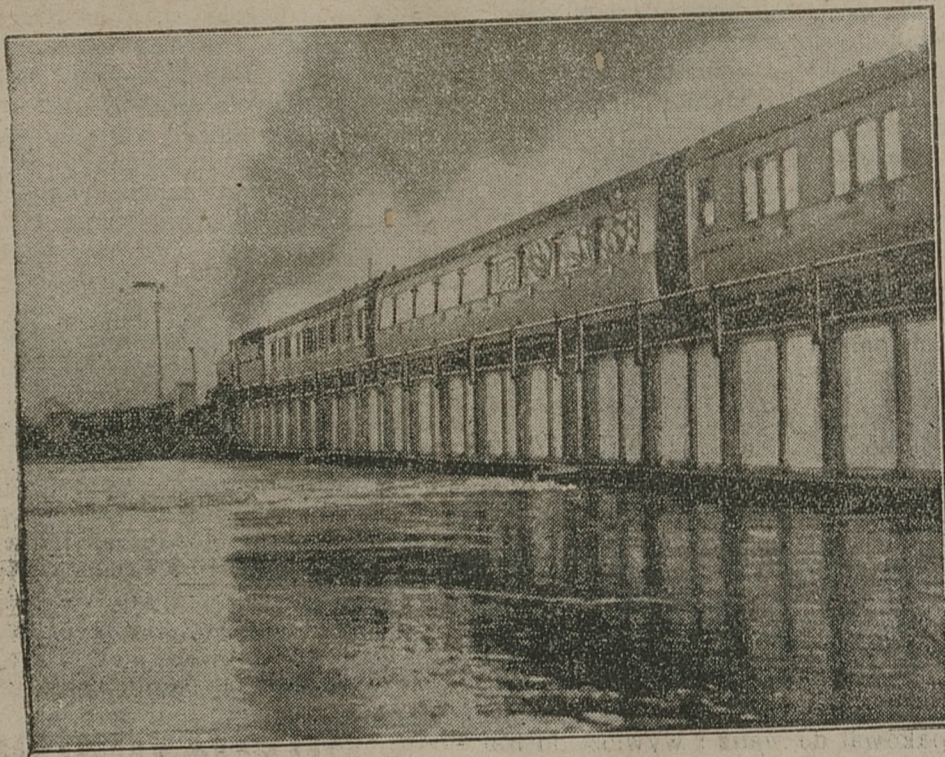
Skutkiem obfitych deszczów w Anglii weszły rzeki do tego stopnia, że przerwały w wielu miejscach komunikację. Na zdjęciu zagrożony most, po którym przejeżdża pociąg.
