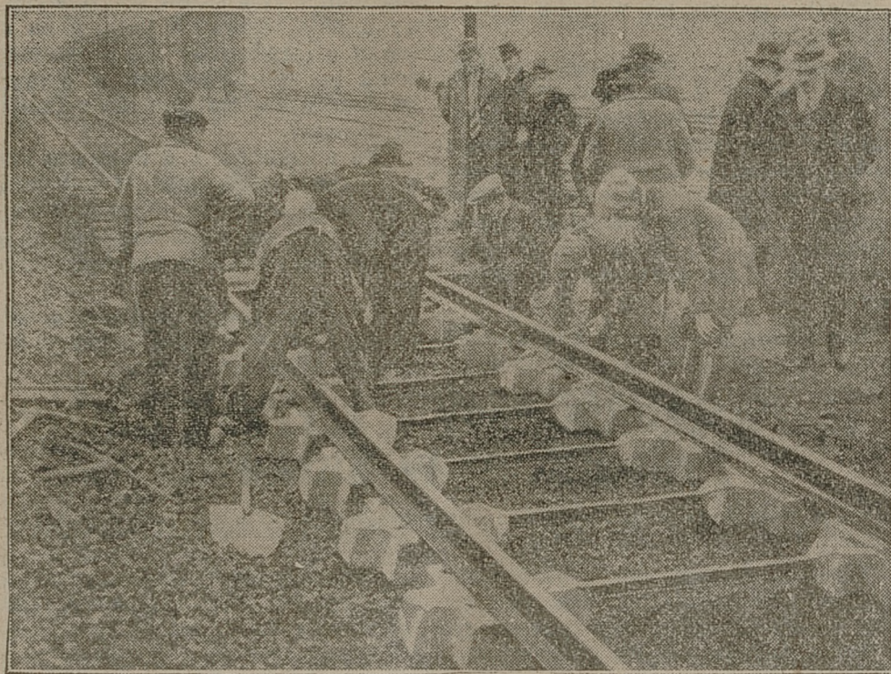
Francuskie koleje wprowadzają cementowe podkłady pod szyny w miejsce drewnianych. Podkłady cementowe są trwalsze i mają gwarantować większe bezpieczeństwo.
