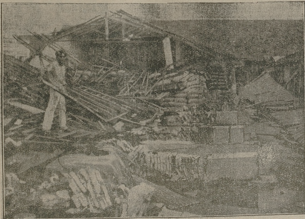
Na Kubie szalał niedawno huragan, który poczynił olbrzymie szkody.
