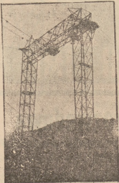
Konstrukcje stalowe przy budowie zapory wodnej w Rożnowie. Wieża wysokości 60 mtr.
