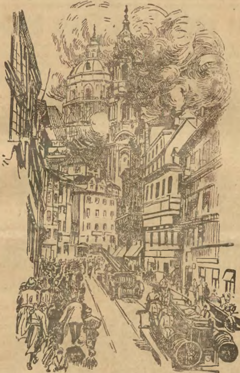
Kościół św. Mikołaja w Pradze Cze skiej, jeden z najpiękniejszych zabytków budownictwa barokowego, nawiedzony został przez pożar, który zniszczył więzania dachowe wieży. Istnieje obawa oberwania się dzwonów.
