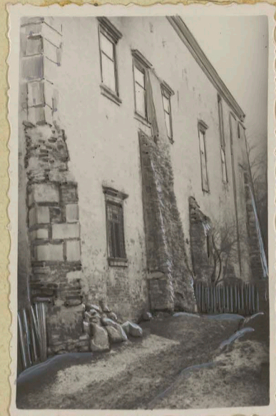
Ściana potłoczona wschodnia dawnego klasztoru
