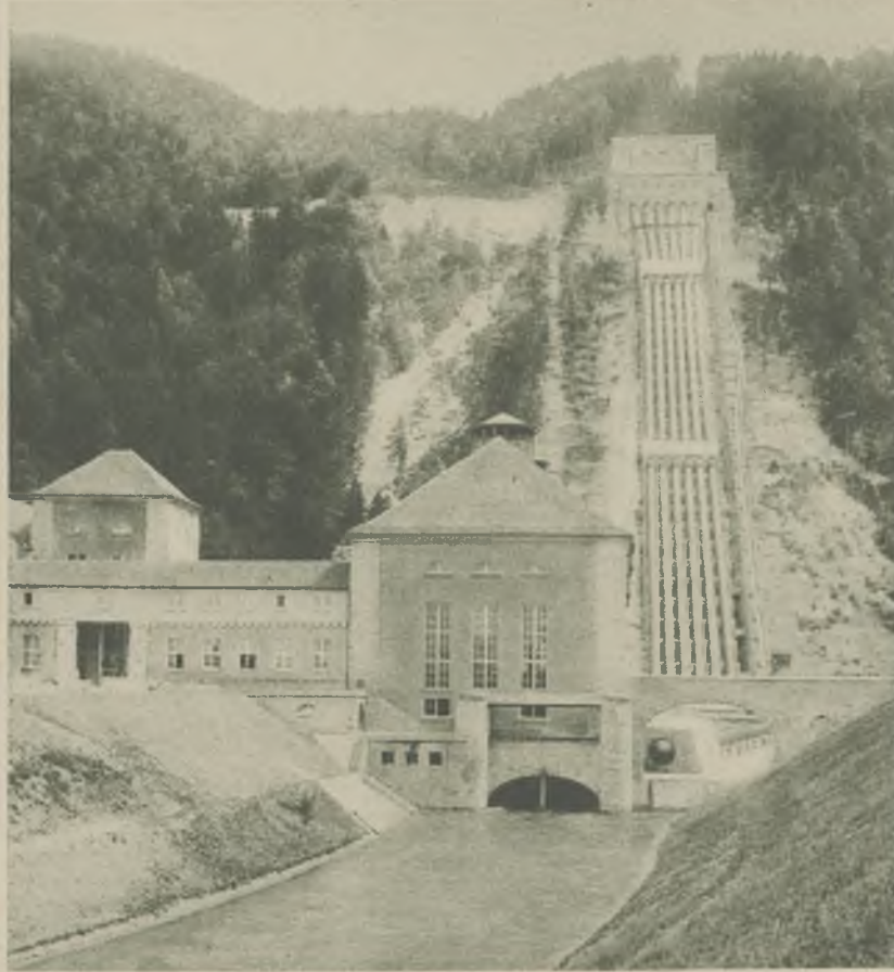
Olbryzia elektrownia. Nad jeziorem Walkensee w Bawarji zbudowano olbrzymią elektrownię, która wykorzystując siłę wody, zaopatrywa w prąd wielkie przestrzenie kraju. Na zdjęciu naszym widać wodospad, ujęty w równoległe biegnące rury o wielkim przekroju. Fot. Frankl.
