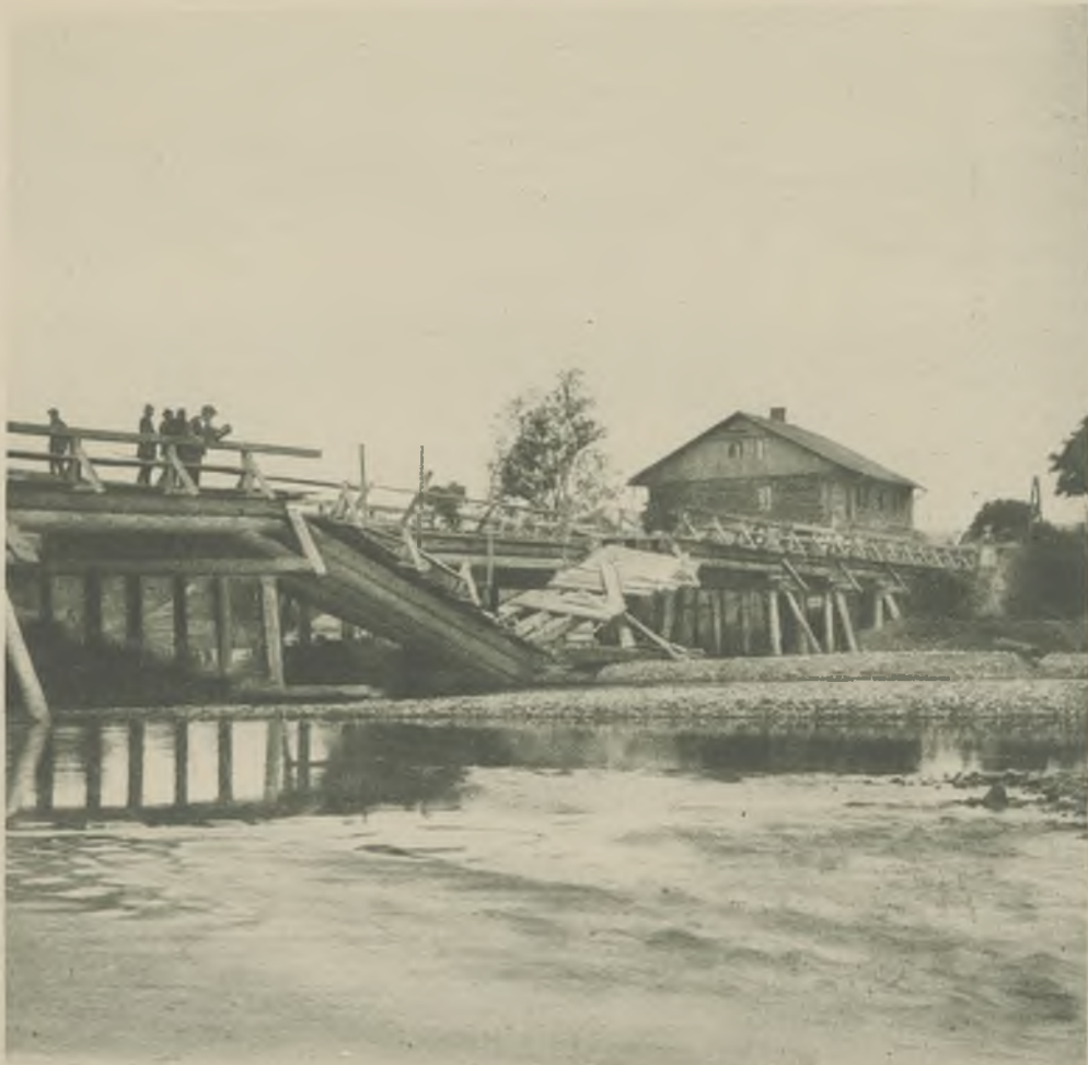
Skutki powodzi w Małopolsce. Drewniany most na Rabie w Dobzycach zawalił się podczas przepędzania kilkunastu sztuk bydła. Zdjęcie nasze przedstawia stan mostu bezpośrednio po katastrofie. Fot. Szczygół.
